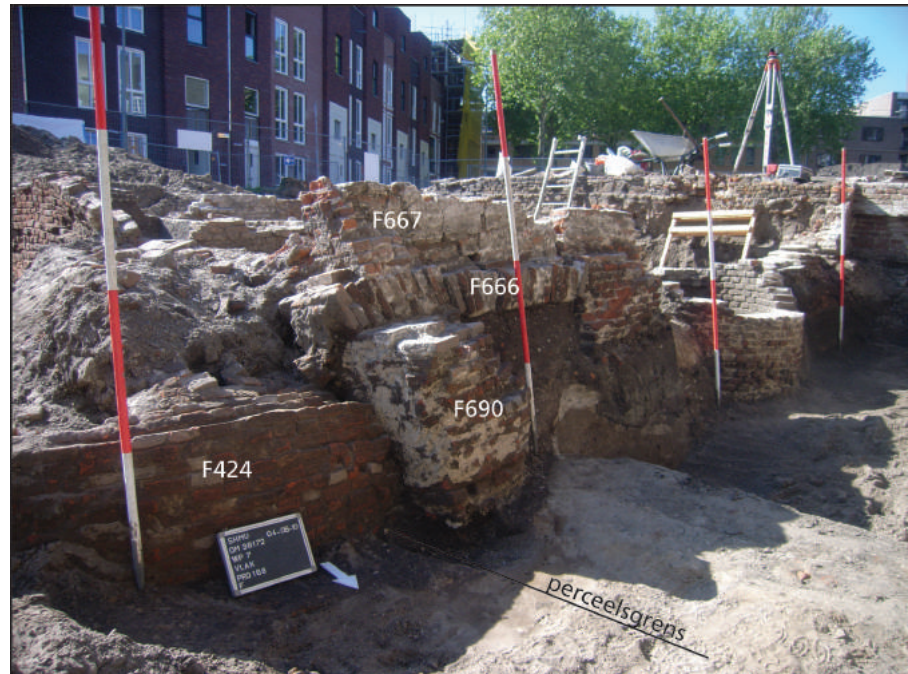
Afb. 4.42 Aanzicht van beerput F424 op perceel 4 en muur F667. Muur F667 is gefundeerd op een grondboog F666, die op zijn beurt op een poer (F690) en op de beerput is gefundeerd.
